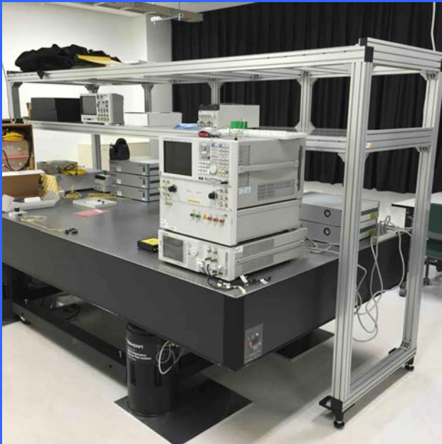
施工例：キャスタータイプ
